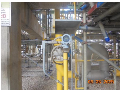
ภาพที่ 3-41 Flammable Gas Detector
