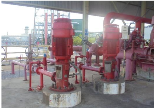
ภาพที่ 3-48 แหล่งน้ำสำรองดับเพลิง และเครื่องสูบน้ำดับเพลิง (ต่อ)
