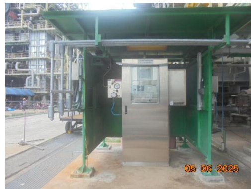
ภาพที่ 3-54 Conductivity Online ที่ Cooling Blowdown
